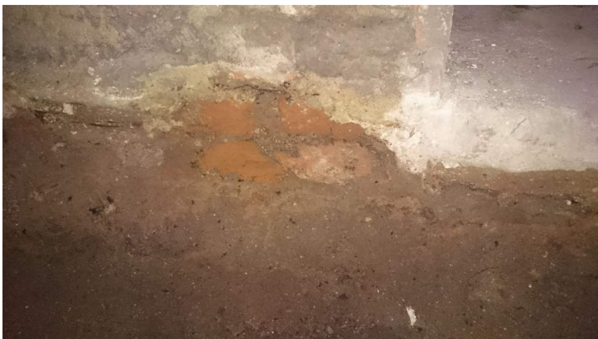
Obr. 30 - Fotografie založení stěny přímo na terénu (fotografie je pořízena ze strany objektu na parc.č. 911 jehož stěna je společná pro rodinný dům na parc.č. 910)
