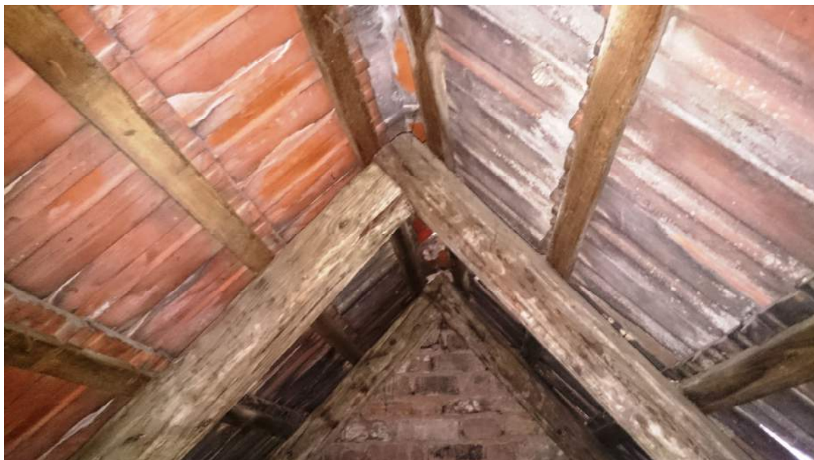
Obr. 32 - Hřeben sedlové střechy s krokvemi a keramickou krytinou
